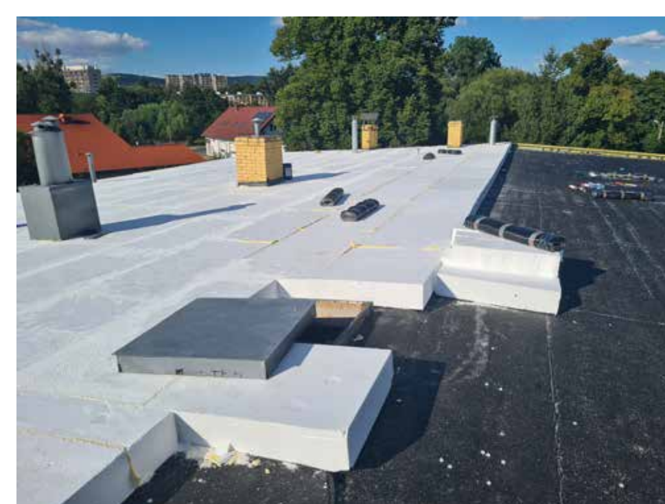
Zdjęcia z docieplenia elewacji Domu Harcerza. W ramach zadania zadbano o najmniejsze detale architektoniczne oraz zadbano o termomodernizację i docieplenie stropodachu (foto poniżej).
